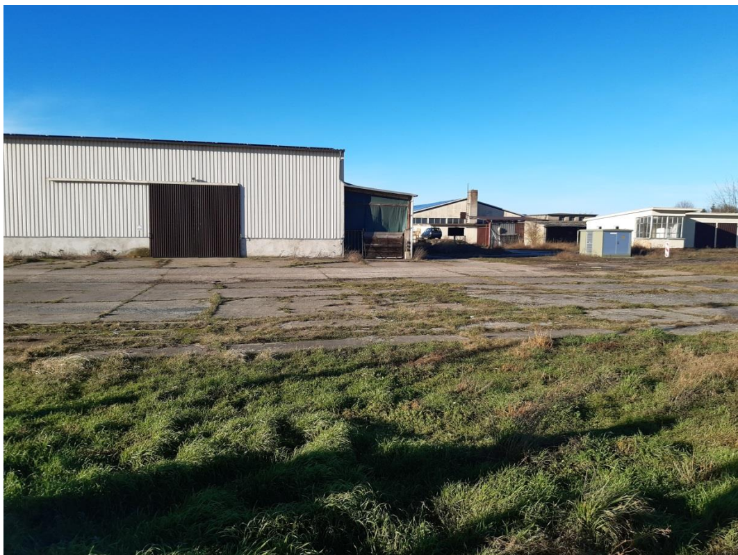
Blick über das Baufeld in westnordwestliche Richtung
